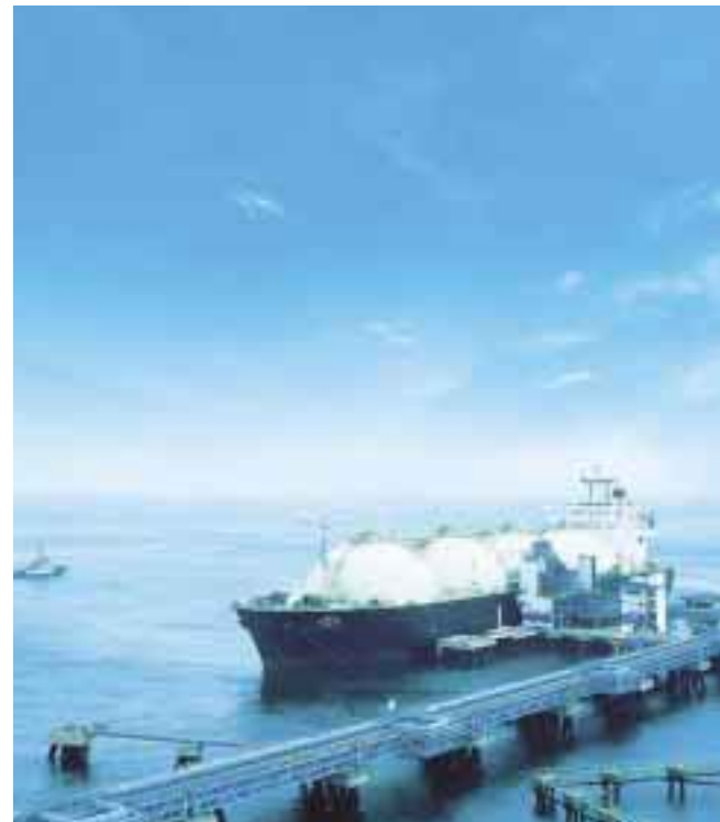
The LNG Flora docked at the Osaka Gas Senboku LNG Terminal II pier.
