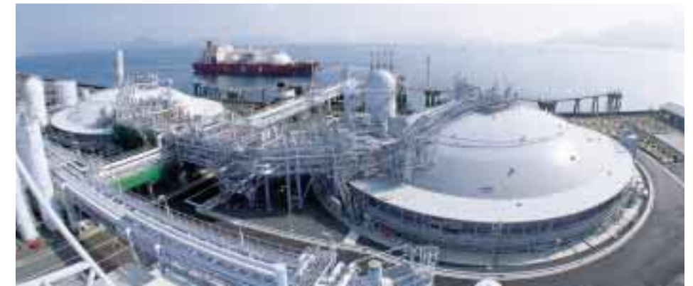
The Hatsukaichi LNG Terminal, Hiroshima Gas.
